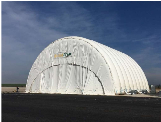
Figura 20. Tancament davanter de l'hangar H20M
