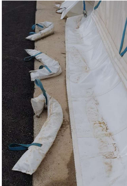
Figura 23. Llastres col·locats en posició per obrir el teló lateral.
