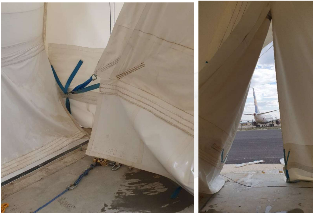
Figura 26. Fixació dels mosquetons a la cinta en "V" de l'extrem (esquerra). Obertura del teló lateral amb aquesta disposició (dreta).
