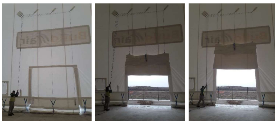
Figura 27. Seqüència obertura de la porta central (ordre d'esquerra a dreta)
