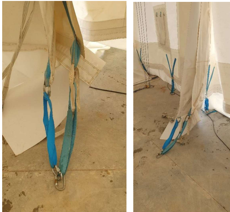
Figura 25. Unió de mosquetons del teló lateral.
