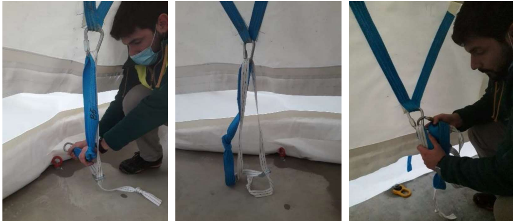
Figura 21. Procés per soltar el punt d'ancoratge (ordre d'esquerra a dreta i de dalt a baix)
