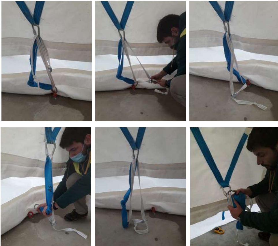
Figura 21. Procés per soltar el punt d'ancoratge (ordre d'esquerra a dreta i de dalt a baix)
