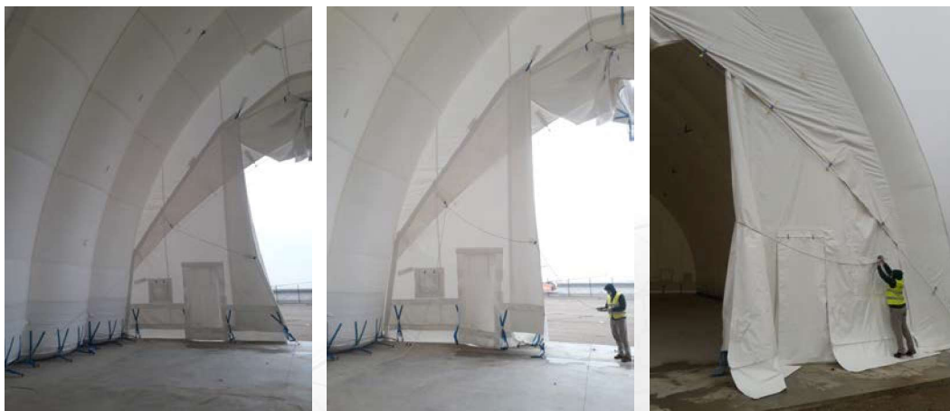
Figura 23. Posició de la corda per recollir el teló lateral
