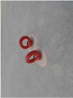
1-ANCORATGE PER A SISTEMA DE TENSORS
